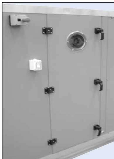
Puerta de registro
